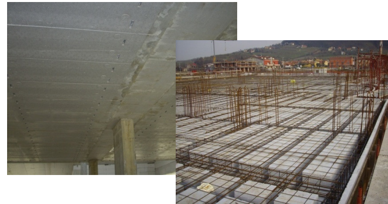
TERMOSOLAIO (6+45) + 5 cm cappa cls
